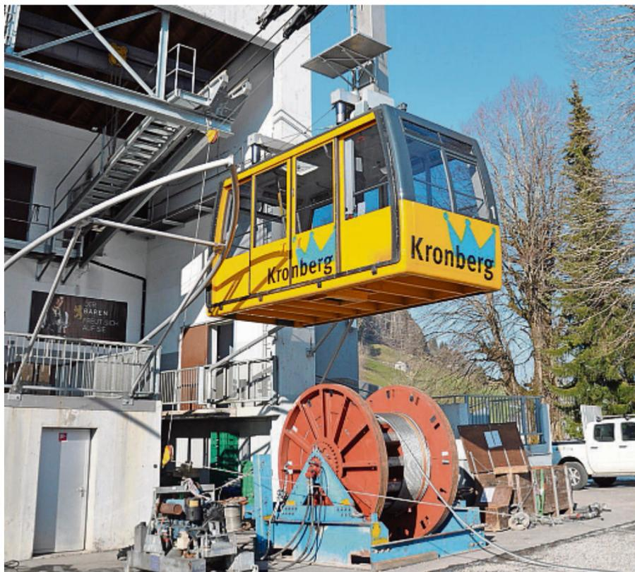
Die Trosse mit dem neuen Zugseil und dem Hydraulikmotor.
